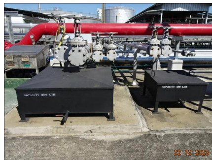
ภาพที่ 2-2 (ต่อ) ถังรองรับน้ำมันที่อาจรั่วไหลจากการถอดและเชื่อมต่อในการขนถ่ายน้ำมันที่ท่าเรือ
